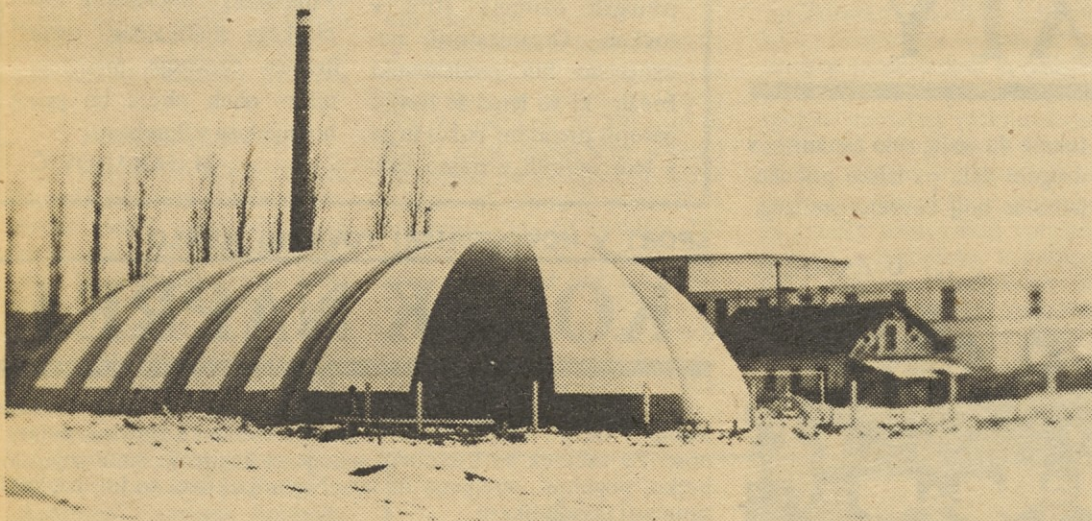
Pred dnevi je pri Tovarni nogavic na Polzeli zrasel nenavaden, velik balon. Ljudje, ki so hodili mimo, so se spraševali, kaj je to. To je novo skladišče iz plastične mase za tovarno nogavic, ki je eno redkih v Jugoslaviji.
