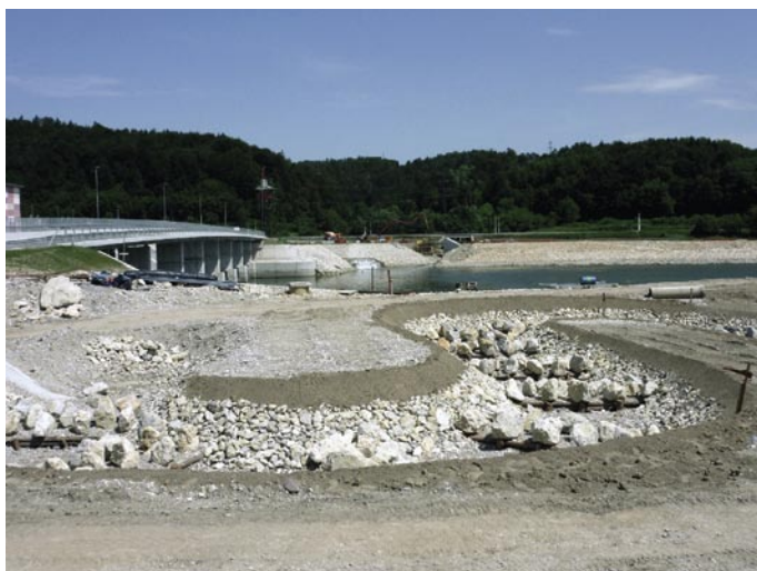
Ob pregradi Blanca je zgrajen po najnovejših standardih zasnovan prehod za vodne organizme. Prehod na fotografiji je še v gradnji.
