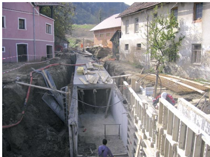
Zaradi omejenega prostora se je za izlivni del Konjščanskega potoka izvedla rešitev s pokritim kanalom.
