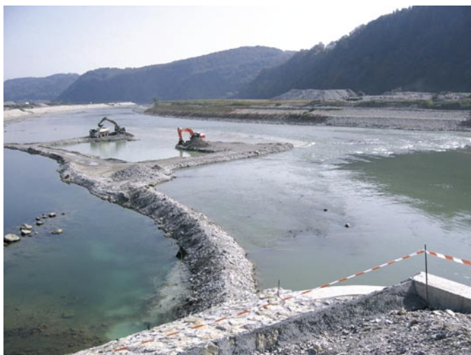
Dolvodno od HE Blanca je izvedeno poglobljanje struge za povečanje izkoristka elektrarne in hkrati povečanje poplavne varnosti vasi Blanca.
