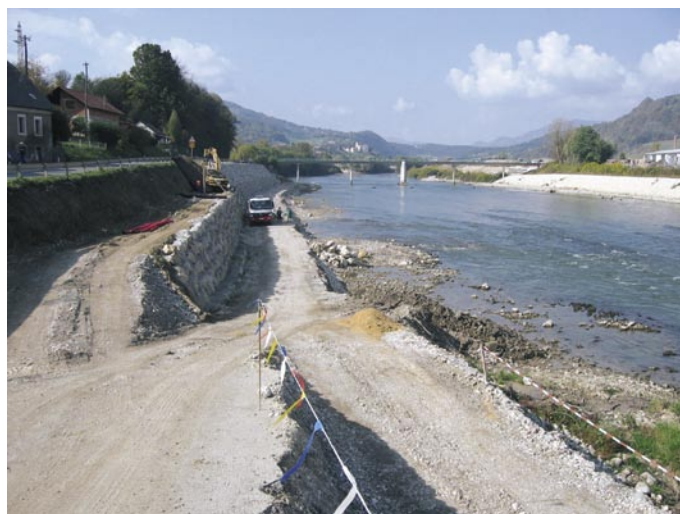
Na več odsekih se je savska brežina protierozijsko zaščitila zaradi bližine infrastrukture – cest, železnice ali daljnovodnih stebrov.
