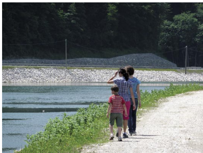
Elektrarna in bazen sicer obratujeta šele poskusno, vendar je krona 2 km dolgega nasipa že sedaj priljubljena rekreacijska točka. V zaključku gradnje bazena so predvidene še dodatne večnamenske in kolesarske poti.
