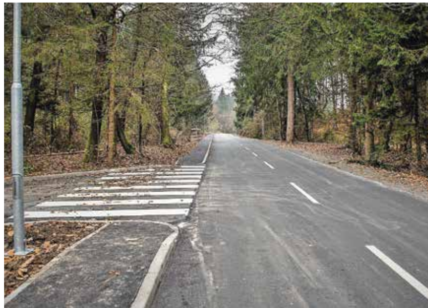
Del obnovljenega odseka s pločnikom
