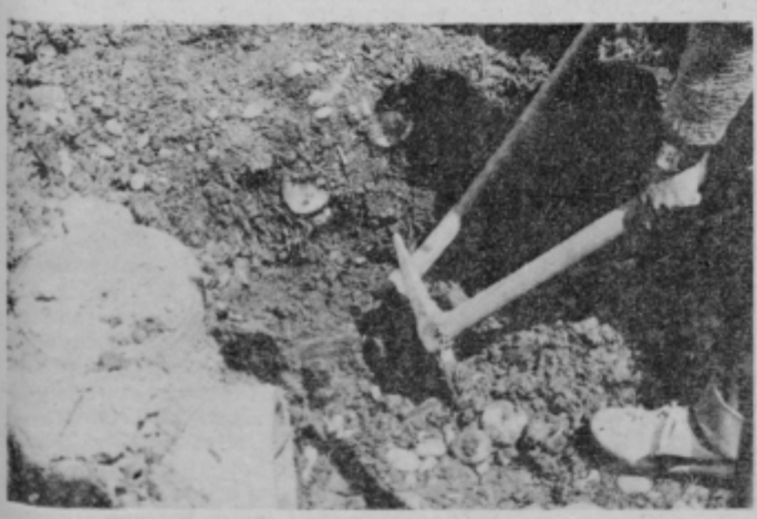
Izkopavanje hidranta iz občestnega jarka.
