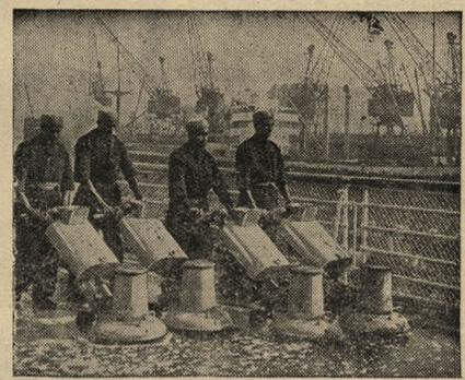
Pronti! Via! Non si tratta di una corsa, ma di una speciale macchina usata nella marina inglese per lavare il ponte delle navi
