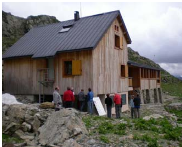
Kočica Pigeonnier z jugozahoda, od koder je videti izhod iz prostorov v nadstropju.
