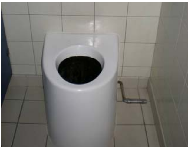
Straniščna školjka v suhem stranišču s pedalom, s katerim uporabniki poganjajo tekoči trak, na katerem se loči blato od urina.
