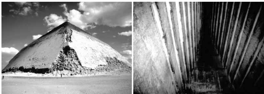
Slika 5: Zapognjena (Bent Pyramid) in Rdeča piramida v sklopu grobnega kompleksa Memfis imata grobne celice v korbelingu. Levo Zapognjena, desno notranjost Rdeče piramide. Zapognjena ima stopničenje še pretežno prekrito z ovojem, ki je pri Keopsovi piramidi, žal, odstranjen. (fotografiji: Borut Juvanec, 2001)
