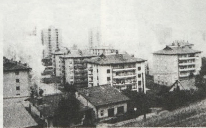
Hud topniški in raketni ogenj je razdejal gosto naseljeno Novo vas v Celju. Tako se je glasila predpostavka vaje. A pogled na zadimljene stolpnice in opustele ulice, s katerih so se stanovalci umaknili v zaklonišča.
