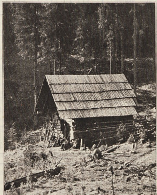
Delavska bajta v odd. 118 b Radovina. Šumska uprava Bled.
