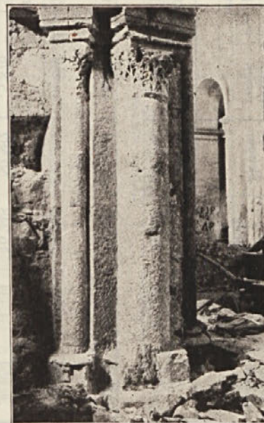
Odkrivanje prvotne arhitekture iz 1. polovice 13. stoletja v kostanjeviški samostanski cerkvi. Šumska uprava Kostanjevica.
