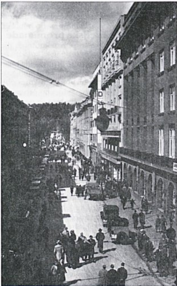
Pogled na promenadno cesto. (vir: fototeka ZAL, enota Ljubljana)
