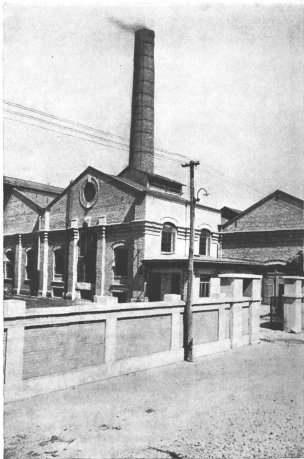
Centrala mestne elektrarne
