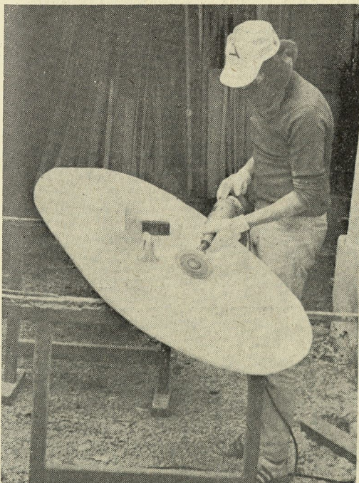
Slika 22. Detajl z izdelave deske — notranja obdelava polovice deske — za brušenje je potrebna ruta čez nos in usta
