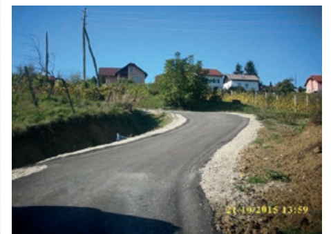
Modernizacija ceste na Strmcu
