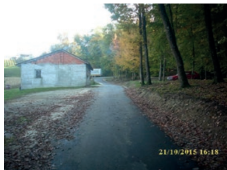
Modernizacija ceste na Humu
