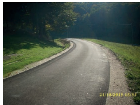
Modernizacija ceste v Velikem Brebrovniku
