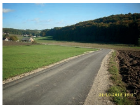
Modernizacija ceste v Miklavžu
