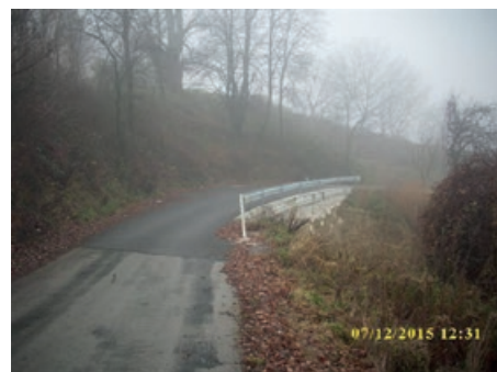
Sanacija plazu na cesti pri Taverni
