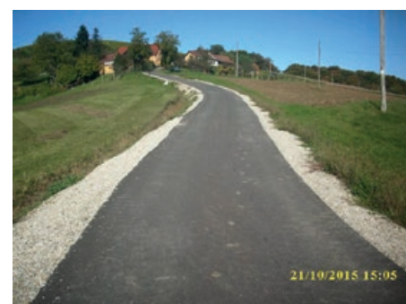
Modernizacija ceste, Mali Brebrovnik
