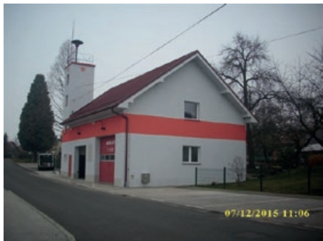
GD Hardek – obnova fasade
