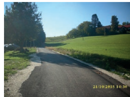
Modernizacija ceste v Ivanjkovcih
