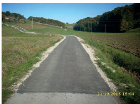
Modernizacija ceste, Mali Brebrovnik
