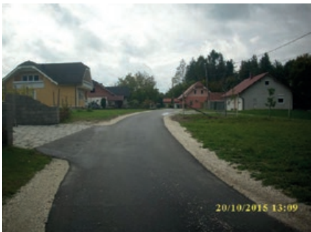
Preplastitev ceste Ritmerk
