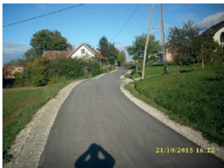
Modernizacija ceste na Humu
