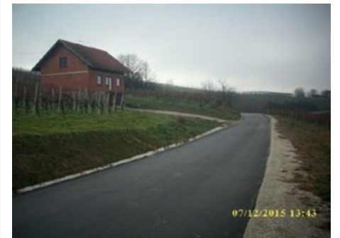
Sanacija plazu na Gomili
