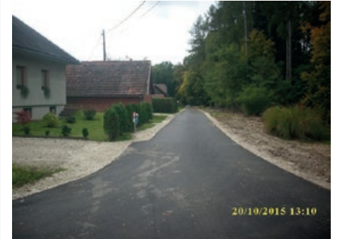
Preplastitev ceste Ritmerk
