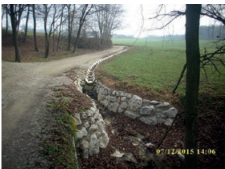
Sanacija plazu na Humu
