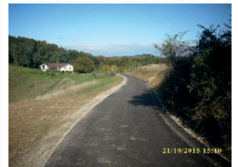
Modernizacija ceste v Velikem Brebrovniku
