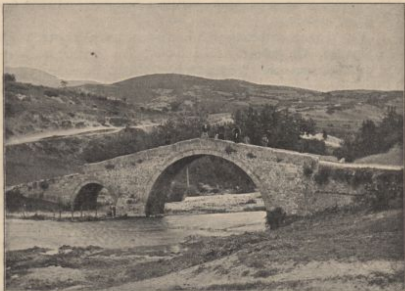
Brücke über den Ana Dere bei Karaferia.
