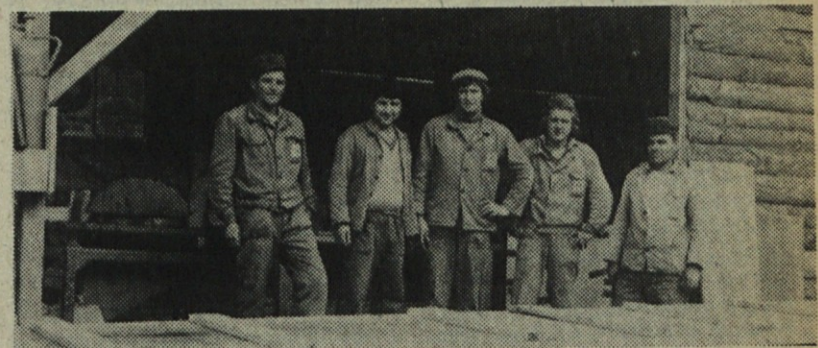
Tesarji pri izdelavi opažev za novo halo Lesne Slovenj Gradec
