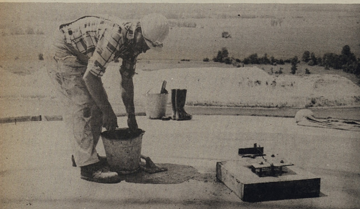
Takole je delavec Ivan Borak zapucal zadnjo lopatico betona na kupoli jedrske elektrarne. — Foto: F. Štromajer
