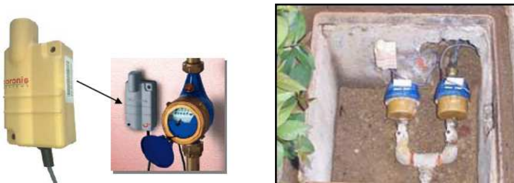
Slika 4.3: Primer zajemanja podatkov iz vodnega števca preko RF povezave [10]
