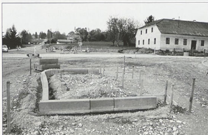
Ob vstopu v občino Zavrč, pred državno mejo, je že nekaj časa veliko gradbišče. V izgradnji je namreč veliko krožišče.
