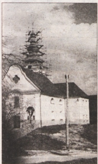
CERKEV V DRAGI OBNAVLJAJO - Konec aprila so začeli obnavljati farno cerkev v Dragi. Prvo so se lotili ostrejša na zvoniku. Temu bo sledilo celotno pročelje, in če bo denar, tudi notranjost. Dragoceni oltarji so namreč močno načeti od črvin in obnova zahteva poseben postopek konzerviranja. Potoški župnik, ki dela vodi, pravi, da bodo dela končali do začetka julija. 11. julija bo škof Jože Kvas dela posvetil skupaj z mrliško vežico, ki je že skoraj dokončana. (A. K.)
