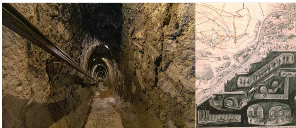
Slika 1: Attemsov vpadnik, ki so ga utrdili in obzidali okoli leta 1766 (levo; foto: Matija Križnar), in načrt idrijskega rudnika, ki ga je izrisal Jožef Mrak leta 1770 (desno)(Wikipedia 1).
