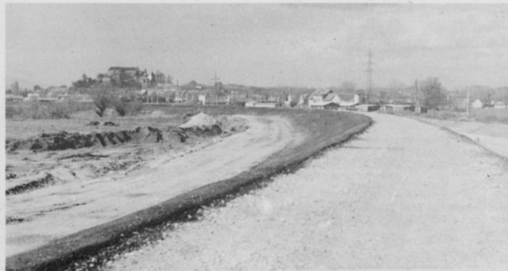
Asfaltiranje notranjih sten nasipa za akumulacijo vode v jezju, ki bo imelo 4,2 kv. km vodne površine. Foto: J. Vrabl
