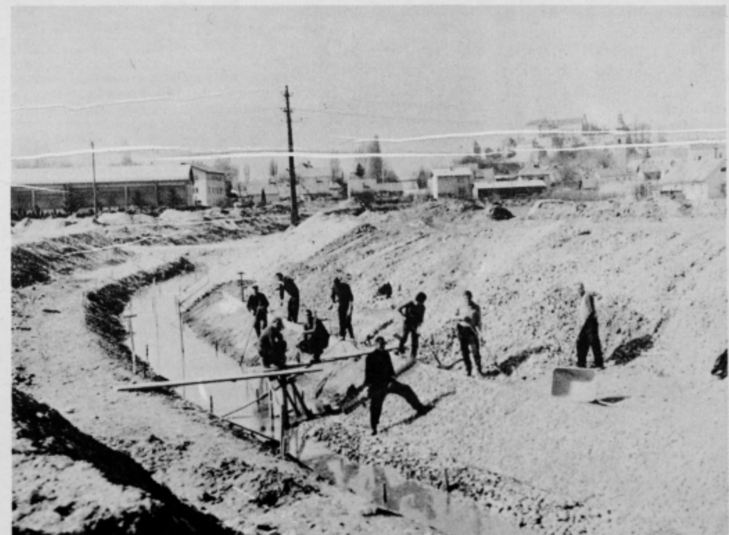
Gradnja odvodnega zbiralca ob nasipu, ki bo zajemal vso zaledno vodo potokov Grajene, Rogoznice in drugih. Foto: J. Vrabl
