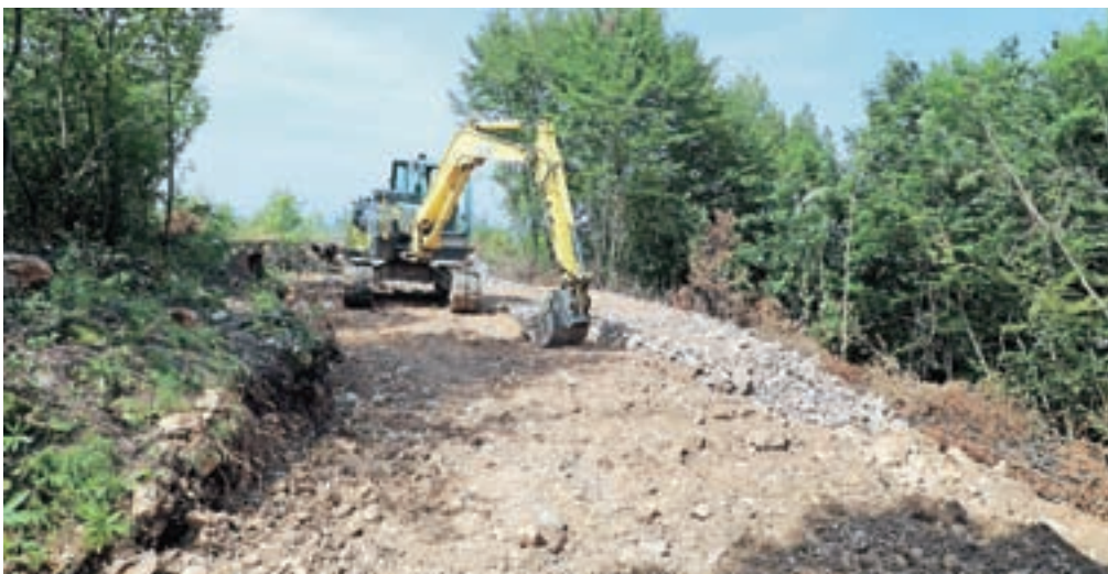
Pripravljala dela so že v teku. / FOTO: TINA DOKL
