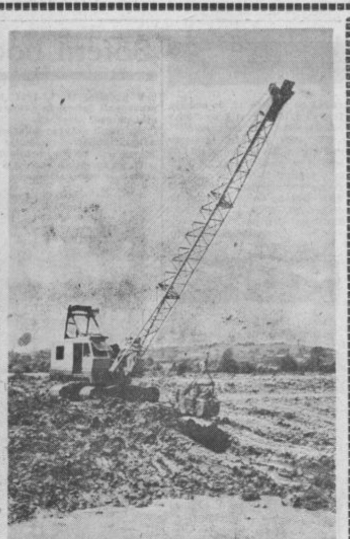
Motiv s Pesnice, kjer bagri poglabljajo glavno strugo. Glavno izkopavanje struge opravijo buldožerji, ki razrinesejo zemljo na obe novi obrežji.
