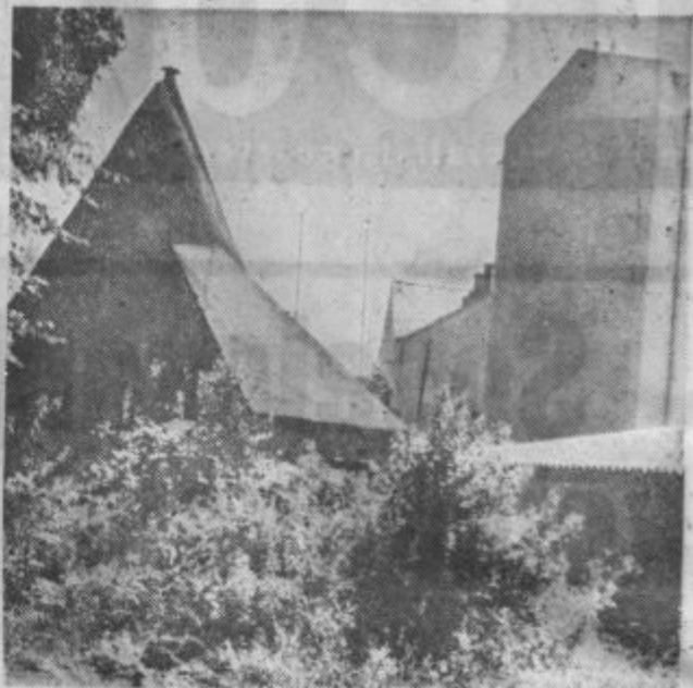
Bujni nasad z ene strani nepotrebne zgradbe v Osojnikovi ulici je izginil, kdo se ga bo lotil še z druge? Sploh je Osojnikova ulica (Lackova ulica—kolodvor) v Ptuju pastorek mestne komunale. Kako dolgo bo še prehodna, če ne bo z nje skoraj odstranjeno do sredine ceste razrito blato?
