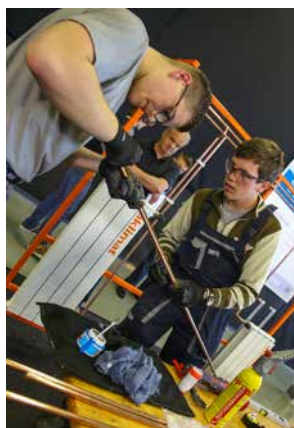
» V poklicu instalaterja stajnih instalacije je delovno mesto zagotovljeno
