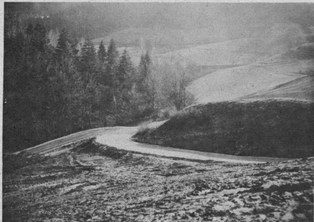
Na tem odseku je bil prej strm, v zimskem času marsikdaj neprevozen klanec
