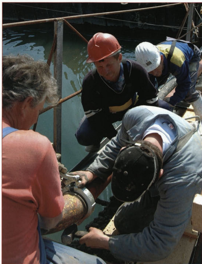
Delavci iz Češke, Slovenije in Ukrajine pri menjavi železne cevi, po kateri spuščajo beton za temeljenje.
