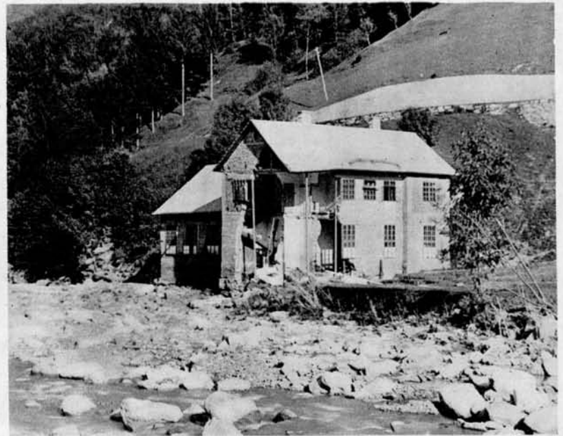
Z zadnje velike povodnji v Sloveniji. Pogled na porušeno žirovsko električno centralo v Fužinah. (Fotografiral P. Podobnik, Gorenja vas.)
