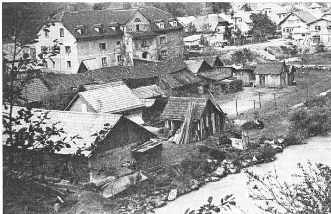
Prevaljske nizke gradnje
