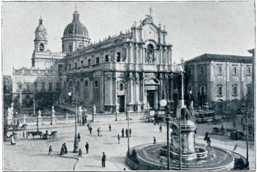
KATEDRALA V KATANII, PORUŠENA OD POTRESA
