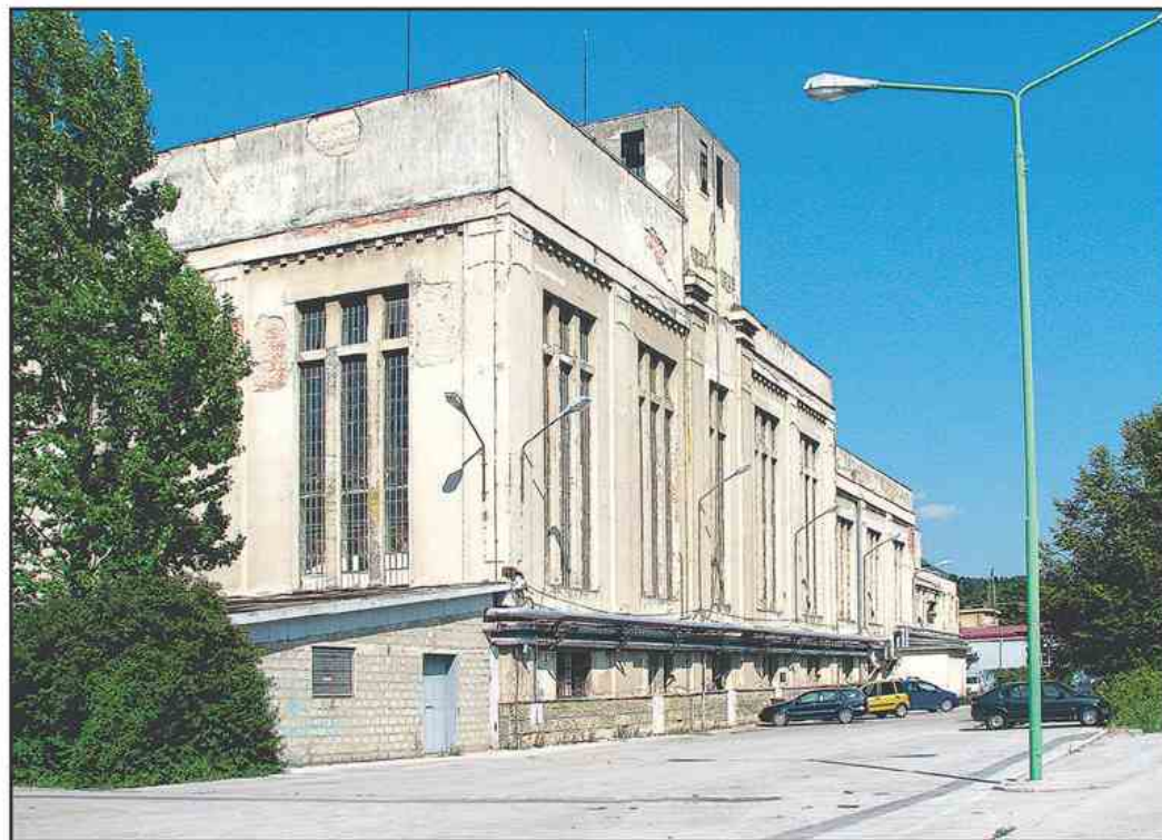
Stara elektrarna je kulturni spomenik industrijske dediščine. Žal vse bolj propada, saj lastniki niso zainteresirani za obnovo.
