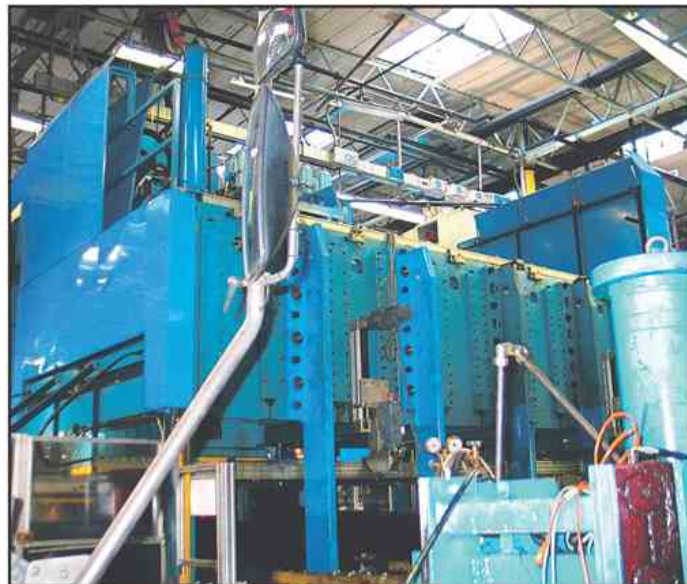
Največja vzdrževalna dela opravljajo v obratu štedilnikov, kjer so med drugim povsem razmontirali tritisočstonsko stiskalnico
