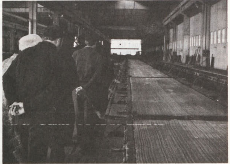
Površinsko obdelani montažni pročelni elementi tik pred razopaženjem
