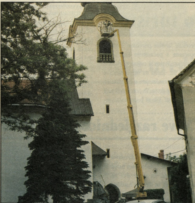
Obnova cerkve sv. Marjete na Polzeli
