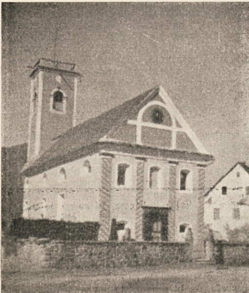
Obnovljena cerkev v Strugah na Dolenjskem
