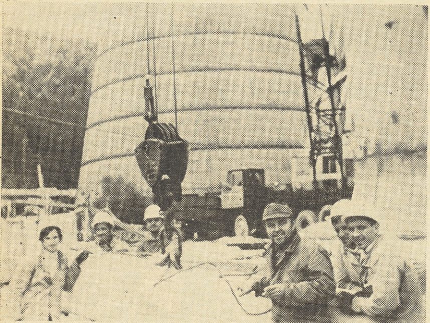
Med graditelji šoštanjanskega hladilnega stolpa
