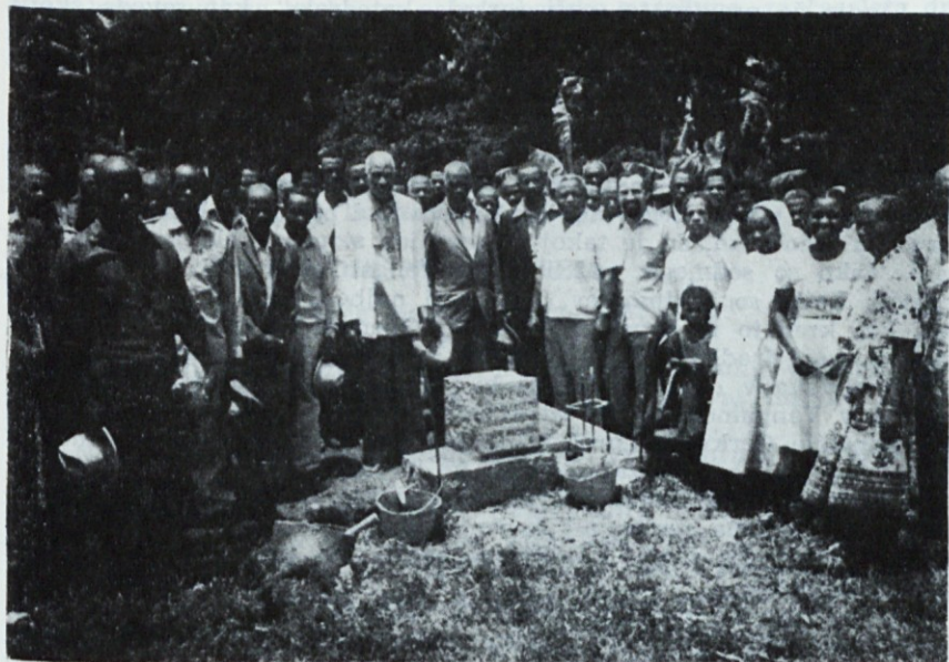
V kraju Manašua je Petrov sodelavec Rado Sušnik na podružnici misijona že blagoslov temeljni kamen cerkvice, ki jo bodo sezidali namesto lesene kapelice. Sušnik na sliki z brado.
