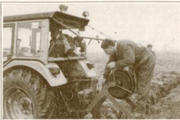
Počasi in natančno so pri Majeričevih v zemljo spravili blizu dva tisoč poroznih cevi
