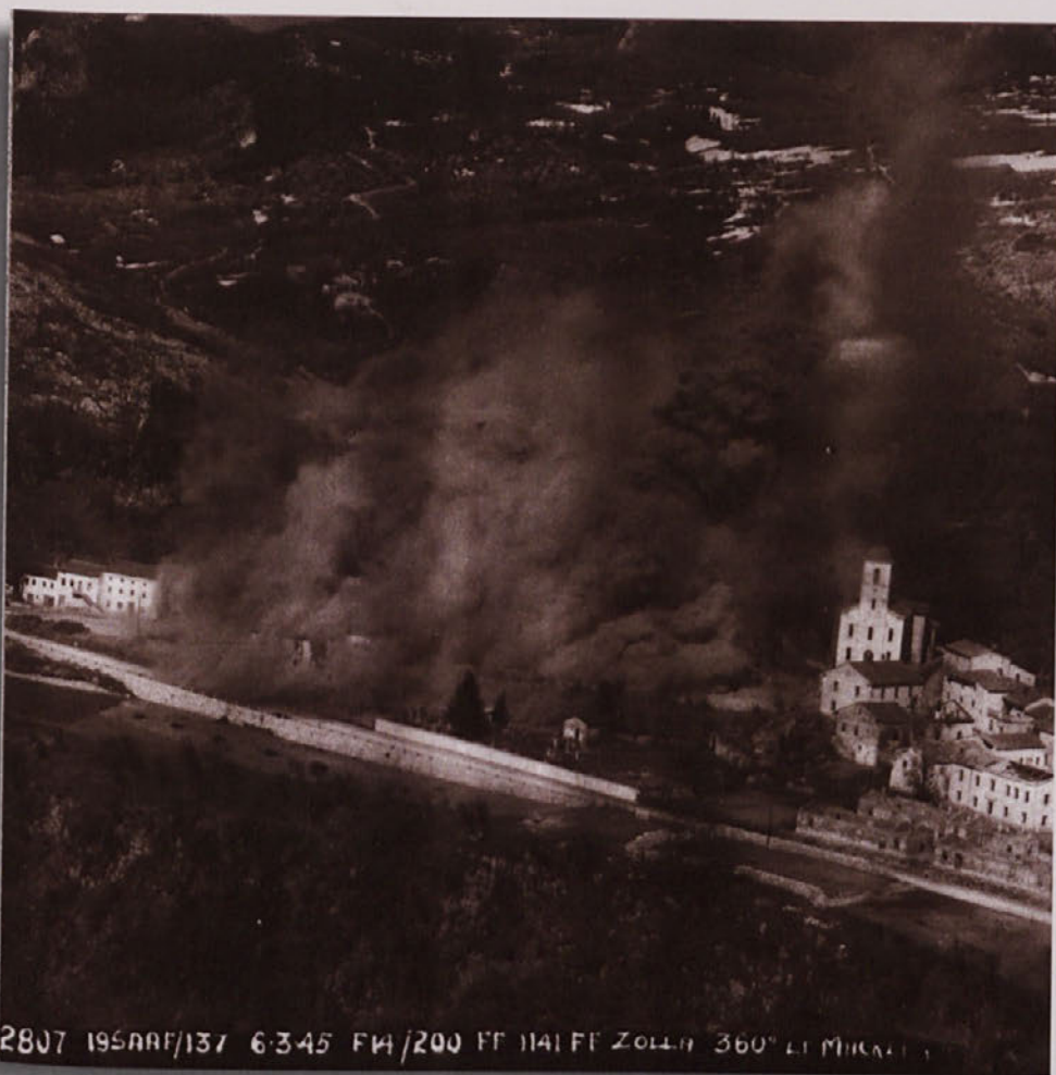
POROČNIK MACKLEY JE NAPADAL KOT PETI. NA FOTOGRAFIJI SE VIDI PORUŠEN SPODNJI DESNI VOGAL MAKSELNOVE KLANICE, MEDTEM KO TRATNIKOVA HIŠA IZGLEDA PRECEJ NEPOŠKODOVANA. NA DESNI STRANI FOTOGRAFIJE SE VIDI POŽGANA SEVERSKA HIŠA, LEVO OD NJE PA STAVBA DRUŠTVA, KI SO JO ZADELI V PRVEM NAPADU. VIDI SE TUDI ZADETEK V ŽUPNIŠČE.
