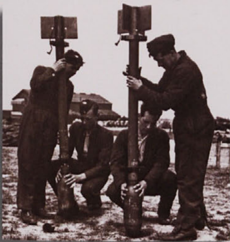
PRIPRAVA POGONSKEGA DELA RAKET RP3. TIK PRED VZLETOM LETALA NA BOJNO NALOGO SO NA POGONSKI DEL RAKETE MONTIRALI ŠE BOJNO GLAVO.
