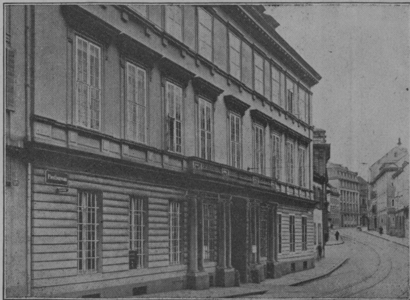
Poslopje reparacijske banke v Baselu. Novo ustanovljena svetovna banka za mednarodna plačila bo nastanjena v poslopu bivšega okrožnega poelvjstva v Baselu.
