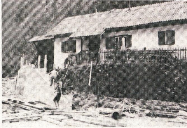
Dela na obrambnem zidu v Stahovici (nasproti Podgornikovih) kar hitro napredujejo.
