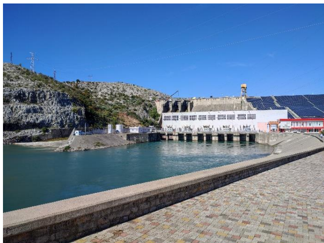
Pregrada Vau Dejes z elektrarno.
