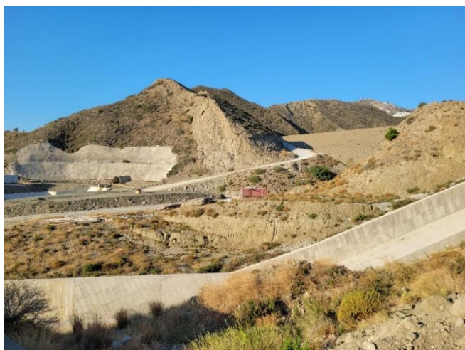
Temeljni izpust in verjetno obtočni tunel v času gradnje (levo), pregrada v desnem delu slike in v ospredju betonska prelivna drča.
