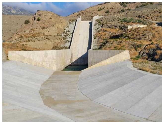
Prelivna drča in podslapje ter utrjen odvodni kanal; ta v podobni, popolnoma betonirani obliki, poteka do izliva v morje pri hotelu Alimounda Mare.
