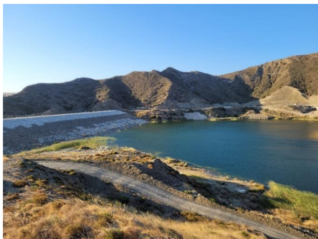
Pregrada z gorvodne strani ter akumulacija.
