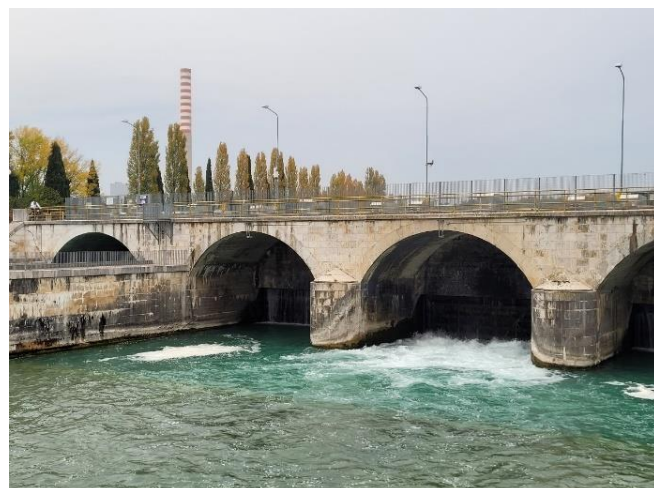
Pregrada »Salionze« z dolvodne strani, v ozadju dimnik TE. Zid na levi strani slike ločuje naravno strugo od derivacijskega kanala.
