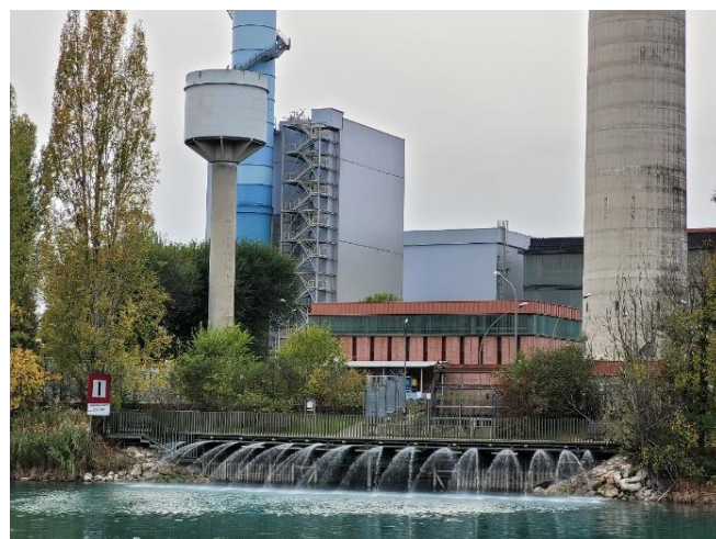
Pogled na drugi breg Mincia: Termoelektrarna neposredno ob reki.
