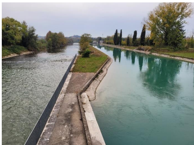
Pogled s pregrade dolvodno po naravni strugi (levo) in kanalu, v daljavi MHE.
