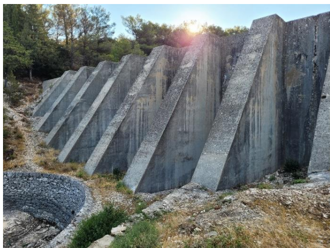
Najvišja pregrada, olajšanega težnostnega tipa.
