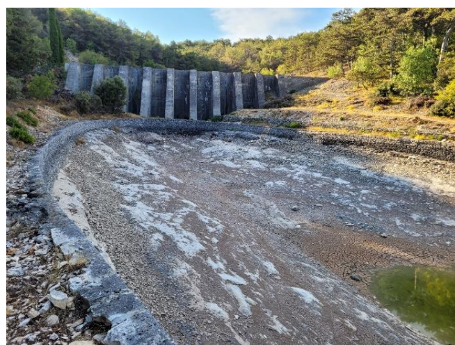
Skrajna gorvodna pregrada in akumulacija pod njo. Vidna je skalna podlaga in zaščitna zložba ob bregu.
