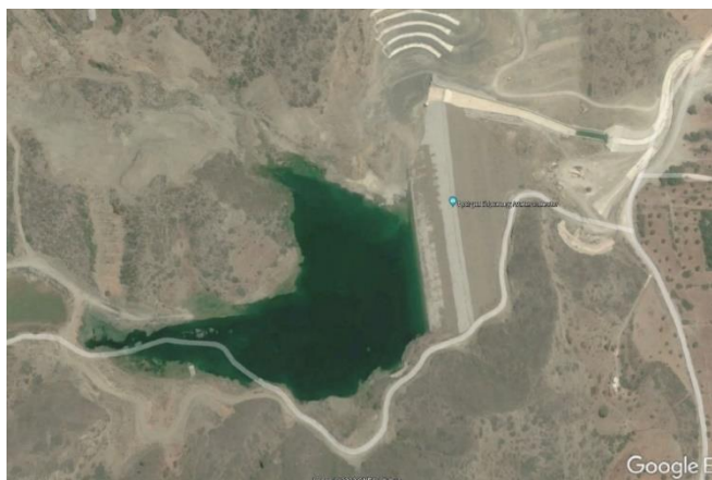
Situacija pregrade in akumulacije na Karpatosu (Pigadia).
