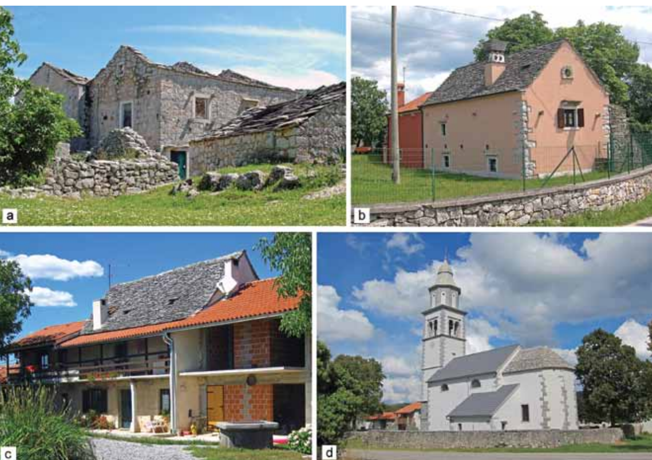
Slika 3: Slabe prakse pri obranjanju in restavriranju kulturne dediščine. (a) Propadanje kamnitih biš v Nakovani na polotoku Pelješac na Hrvaškem, (b) posnemanje vernakularne arhitekture v Zgoniku na italijanskem Krasu, (c) mešanje kritin v Kazljah, (d) zamenjava avtohtonih apnenčastih škrl z industrijskimi strešniki na cerkvi sv. Lovrenca v Kazljah. Foto: arhiv projekta RoofOfRock.
