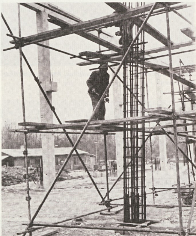
Tesarji se pripravljajo da bomo izdelali opaž notranjih stebrov pri proizvodni hali Svile
