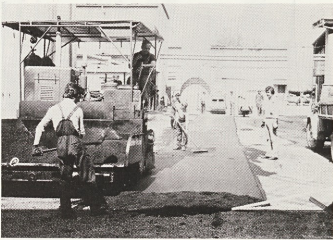
Delavci Slovenija cest asfaltirajo dvorišče med kotlovnico, mazutno postajo in barvarno
