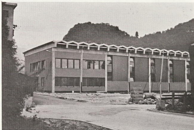
Napeljavo strelovoda na oplemenitilnici izvajajo elektrikarji ETP Kranj
