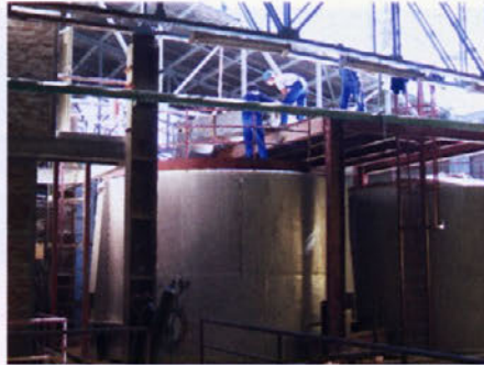
Montaža opreme (+18 metrih)
