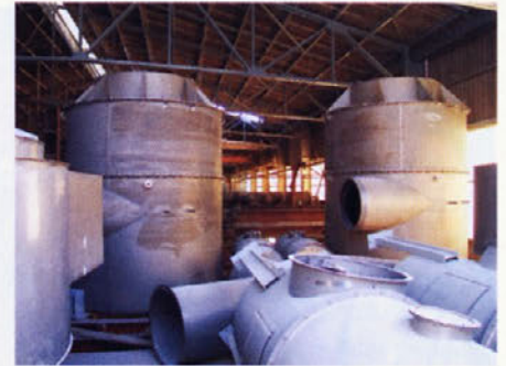
Montaža opreme (+18 metrih)
