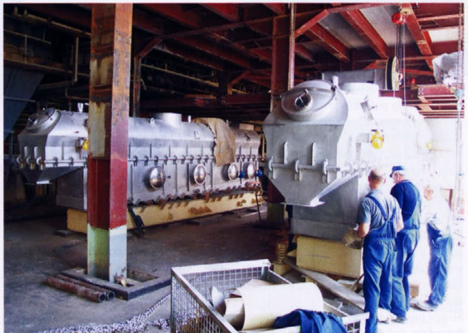
Montaža sušilnikov (+6 metrih)
