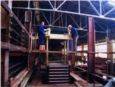
Montaža filter stikalnice (+18 metrih)
