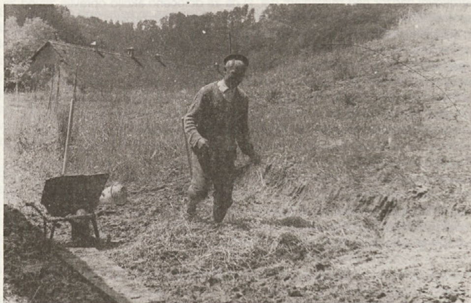
Delavec z bosimi nogami gnete ilovico, pšenično pleve in slamo za pripravo zidu - MNP Rogatec (foto: V. Hazler 1985)
