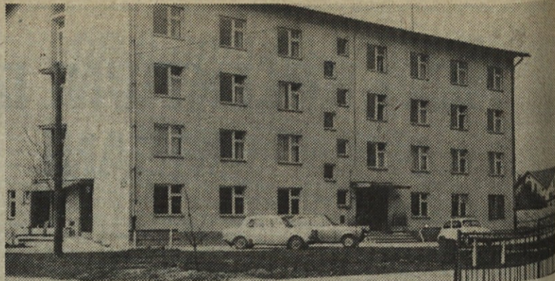
Samski dom na Hudinji v Celju, ki je že nekaj let premajhen zato so celjski gradisovci poleg tega zgradili novega, kjer bo prostora še za okrog 300 delavcev
