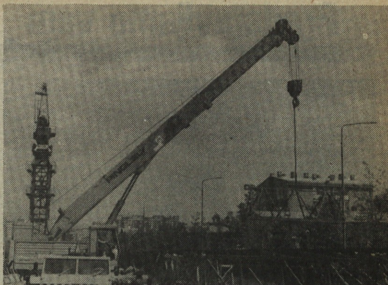
Montaža novega žerjava znamke LM HC 190
