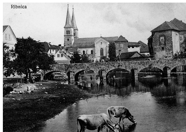
Pogled na »francoski most«, ribniški grad in cerkev.
