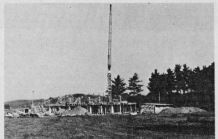
Primarni pokopališki objekt v gradnji.
