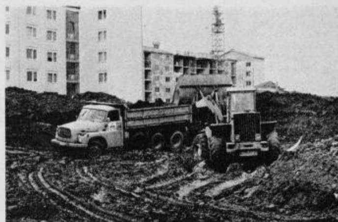
Dela pri izkopu temeljev za B-4 se nadaljujejo.
