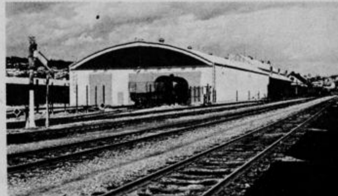
Nova hala Centralnih delavnic, TOZD za vzdrževanje voz (Železniške delavnice) v Ptuj. Foto: R
