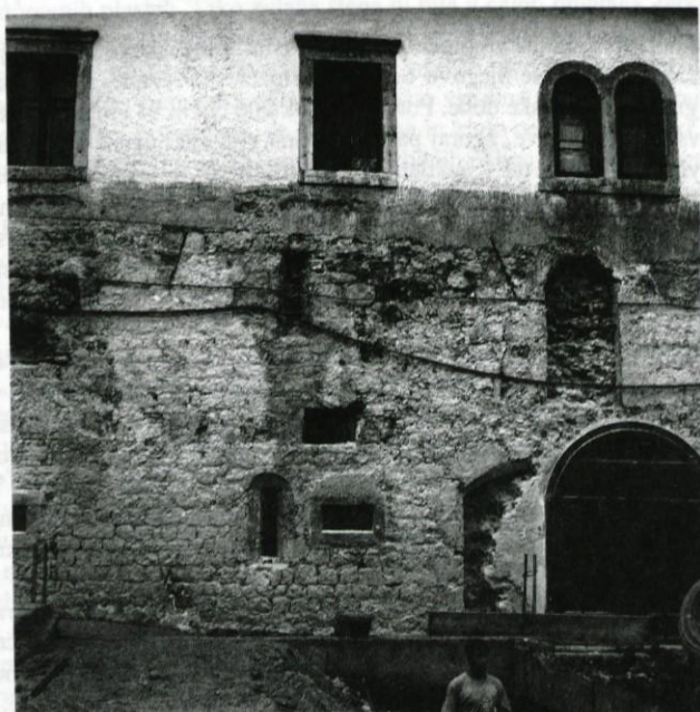
Stična: Zahodna stena bratovskega trakta z značilno romansko zidavo, pritličnimi in nadstropnimi pokončnimi romanskimi okenci, luknjo za tramove in romanskim vhodom v nadstropju. Foto: M. Z.
