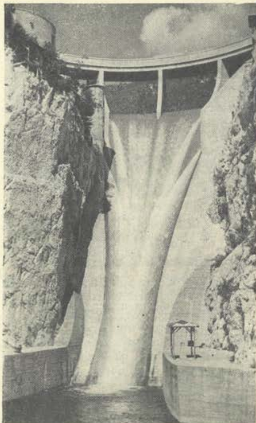
Hidroelektrarna Moste pri Zirovnici na reki Savi; dotok vode je večji od zmogljivosti vodnih turbin in odvečna voda pada preko jezua v krasnem slapu, visokem nad 50 metrov
