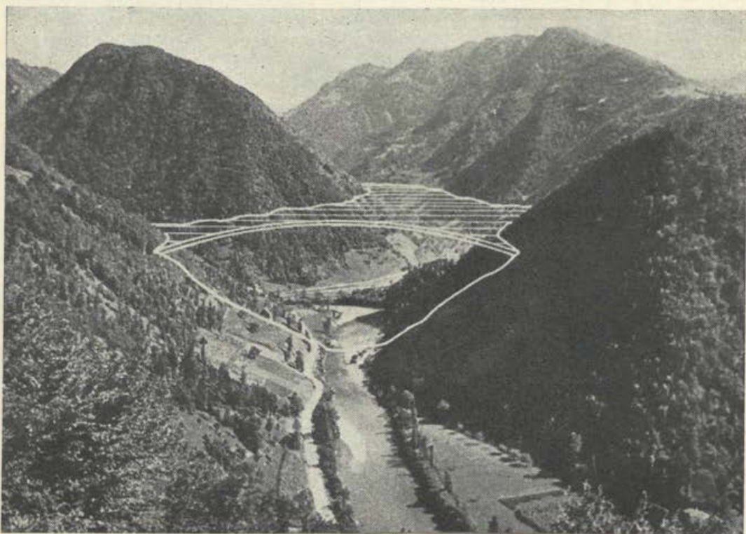
Prihodnja hidroelektrarna na Idrijci; bele črte kažejo obrise 100 metrov visokega jezua in umetnega jezera, ki bo nastalo za jezo
