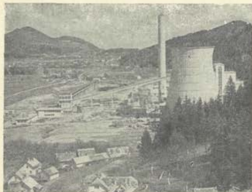
Nova termoelektrarna Šoštanj. Na desni strani se vidi šestdeset metrov visoki stolp iz betonske lupine
