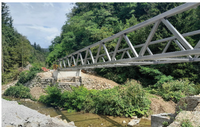
Slika 10. Jeklena konstrukcija mostu M2 čez reko Pako, avgust 2022.
