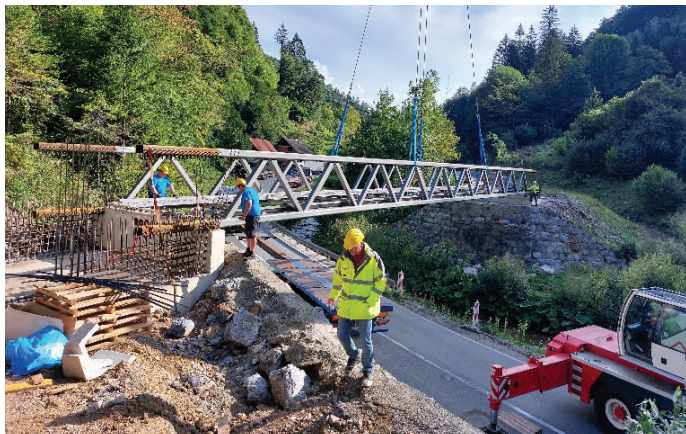
Slika 8. Montaža jeklene konstrukcije nadvoza N2 s pomočjo avtodvigala, avgust 2022.
