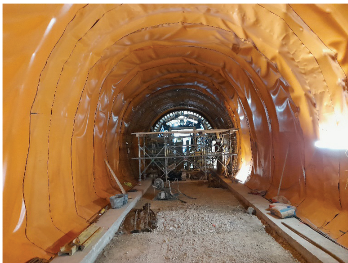
Slika 6. Gradnja novega predora Legi kamen, izvedba hidroizolacije, september 2022.
