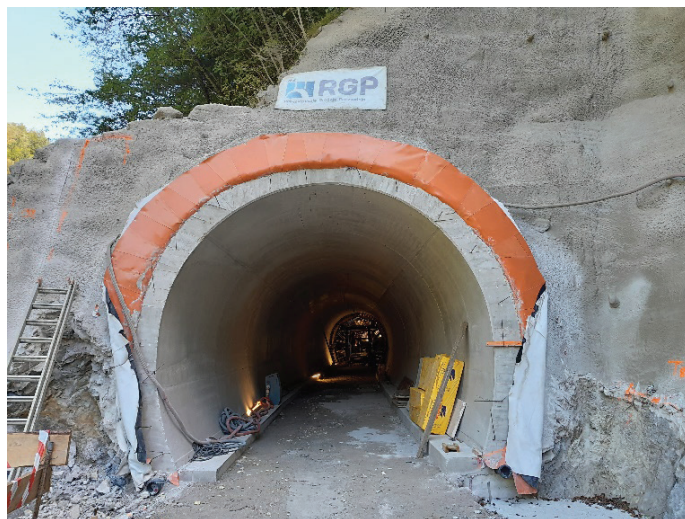
Slika 7. Gradnja novega predora Legi kamen, izvedba sekundarne AB-obloge, september 2022.
