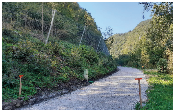
Slika 13. Izvedba podajno-lovilnih ograj za zaščito pred padajočim kamenjem, september 2022.
