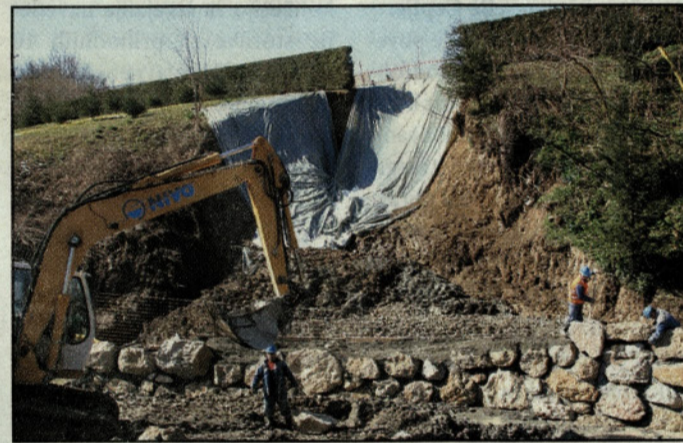
Delavci podjetja Nivo Celje pri sanaciji plaz v Grižah
