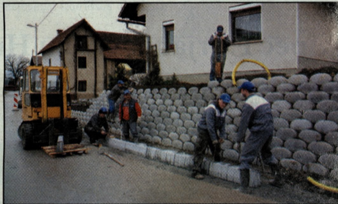
Med izvajanjem del
